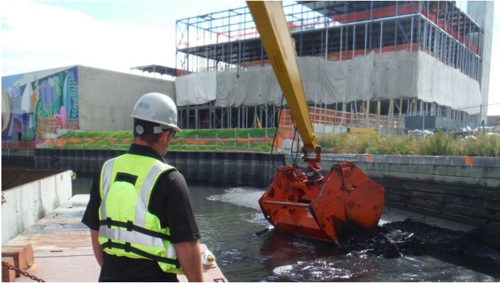
Excavadora eliminando sedimento de la cuenca de 4 th Street del Canal Gowanus en 2018
