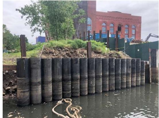
*Figura 1: Muro de contención de pilotes tubulares en la dársena de maniobras de 1<sup>st</sup> Street*
