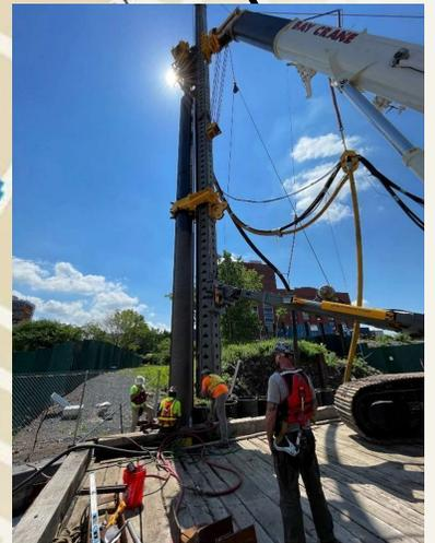
*Instalación de muro de contención de pilotes tubulares en la antigua dársena de maniobras de 1st Street*
