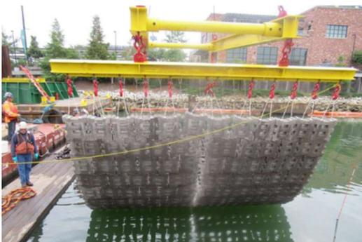
Colocación de esteras de concreto articulado en 4<sup>th</sup> Street Turning Basin
