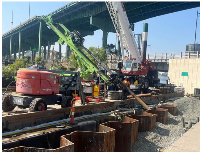
Cuadrillas instalando amarres de mamparo a lo largo del Canal
